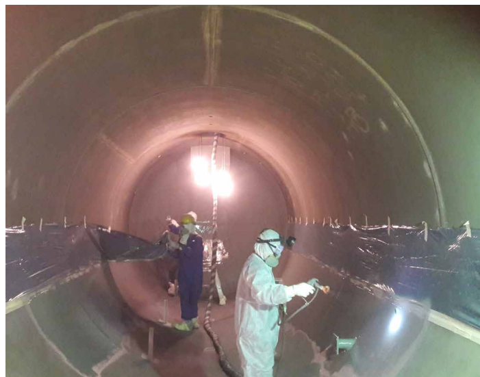
已喷涂贝尔佐纳(Belzona) 1391S
